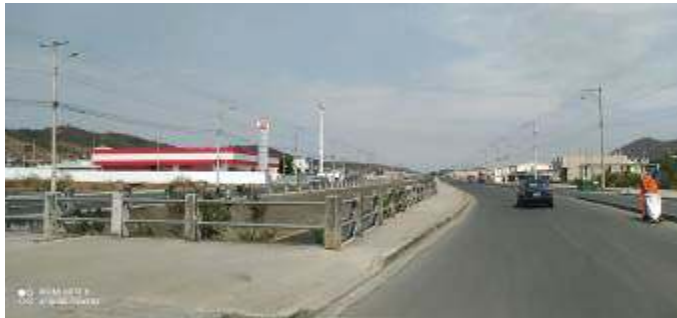
Fotografía 56. Vista puente a través de Estero San Eduardo sector Mi Lote
