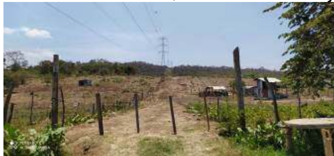
Fotografía 44. Vista paso línea quinto acueducto paralela a la de franja de Alta Tensión
