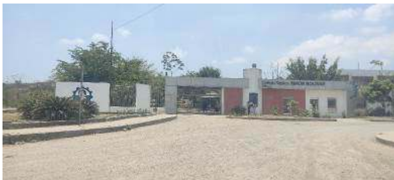
Fotografía 66 Sitio donde se conecta a una tubería existente para abastecer a ciudad Victoria
