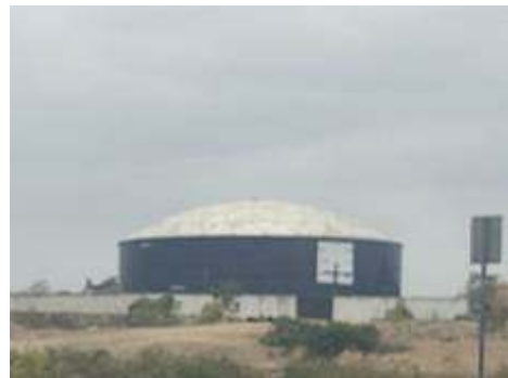
Fotografía 18 Tanque de reserva Ciudad Victoria
