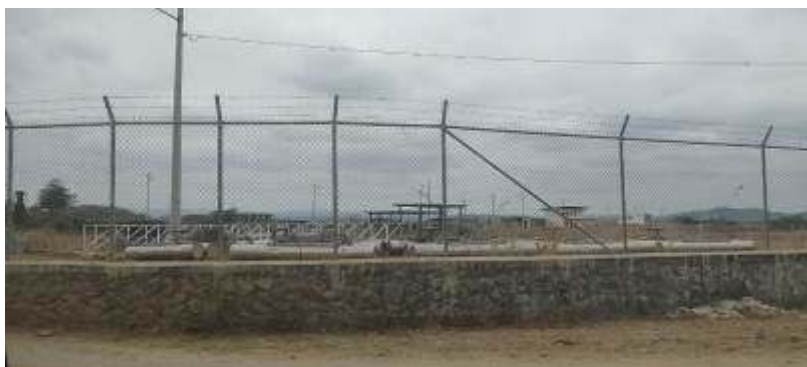
Fotografía 53 PTAR Planificada Mi Lote
