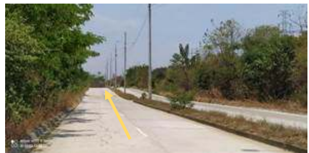
Fotografía 8 Vía a Chorrillos por donde atraviesa el acueducto
