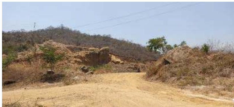
Fotografía 61 Acceso a nuevo reservorio en Ciudad Olmedo
