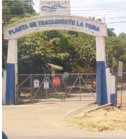
Fotografía 38. Entrada principal PTAP La Toma
