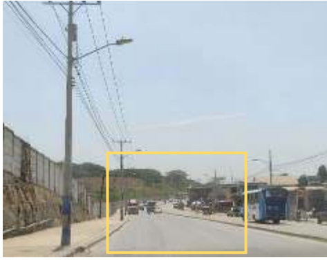
Fotografía 15 Vías por donde está planificada la construcción del acueducto
