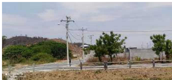
Fotografía 58. Vista Tanque Mi Lote
